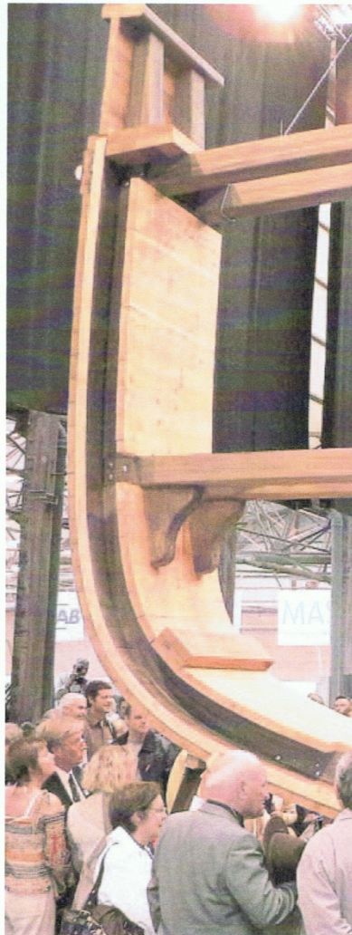
Kjølhal: En kopi er under oppføring. Tømrerelever står for arbeidene på båt
